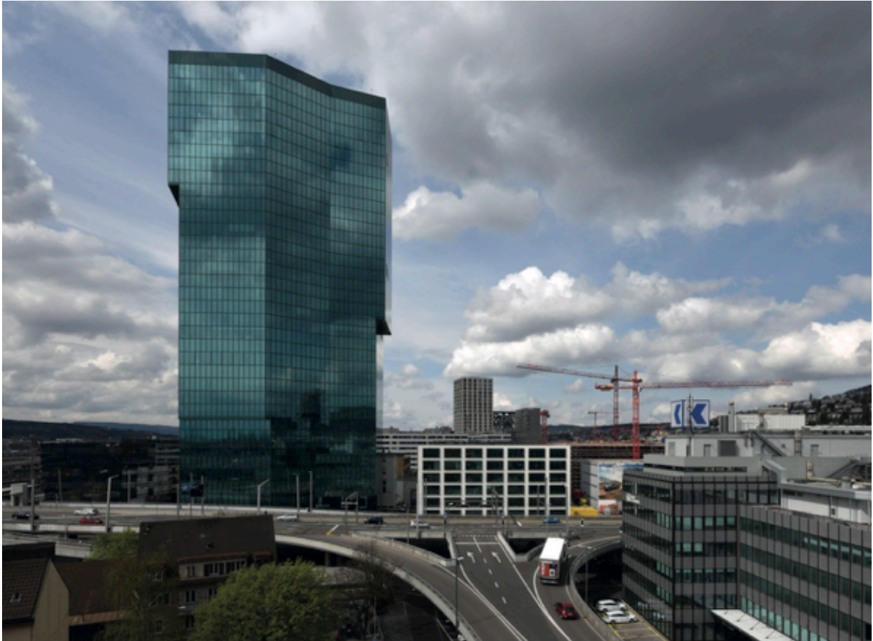
Der Prime Tower setzte 2011 den vorläufigen Höhepunkt in Zürich.
